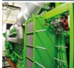
Las centrales de cogeneración instaladas en las fábricas del grupo BMW<sup>1</sup> en Regensburg y Leipzig pueden generar energía in situ y capturar el calor residual del motor para su uso en los procesos de producción de la fábrica. La calefacción en invierno se obtiene a través de una combinación del calor residual de los motores y el calor de las calderas existentes.
