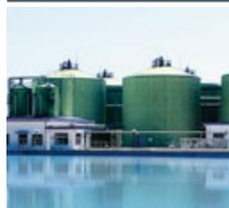
El sistema de generación de electricidad a partir de biogás de Shandong Minhe, en la ciudad de Penglai, funciona gracias a tres motores J320, instalados en 2009, y un motor J620 adicional, que se instaló en el año 2018. La planta puede llegar a alcanzar una generación eléctrica de 6,2 MW utilizando biogás, que se produce a partir de gallinaza de pollos y de la fermentación de aguas residuales.
