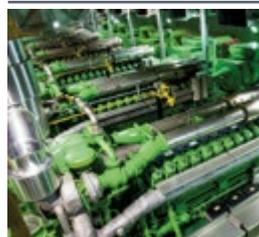
Con un total de seis motores Jenbacher J624 que funcionan con Gas Natural, la planta de Hakha, en Daejeon, alcanza 25.182 kW de potencia eléctrica, así como una eficiencia total del 87%. La instalación de estos motores Jenbacher ha hecho de la planta, una de las plantas de motores a gas más grandes de Corea del Sur.
