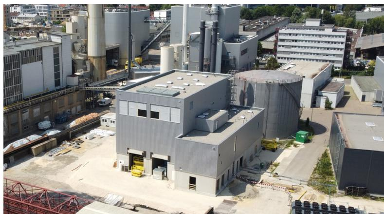
ersetzt wird. Sämtliche Kessel erzeugen Dampf, der direkt in das bestehende Dampfnetz der FUG eingespeist wird und die drei hydraulisch getrennten Wärmernetze über Dampfumformstationen versorgt.
