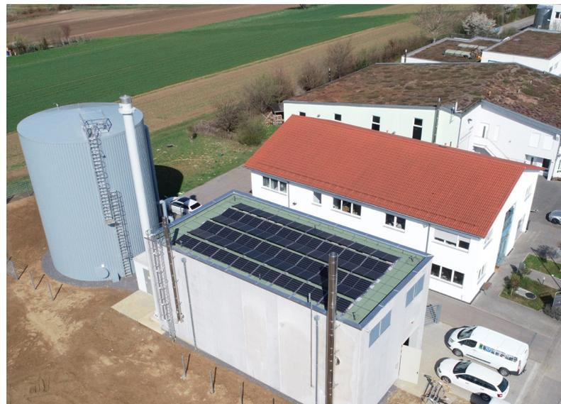
Dank des großen Pufferspeichers lassen sich 750.000 Liter Wasser als Wärmespeicherung aufnehmen. Zudem schafft der Pufferspeicher die Option, das BHKW strommarktgeführt und flexibel zu fahren.
