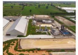
Cinque motori a biogas Jenbacher J420 producono più della potenza elettrica necessaria per alimentare lo stabilimento di amido di tapioca di Chok Yuen Yong Industry Co., LTD. L'energia elettrica prodotta in eccesso viene trasferita dai motori, circa 1.000 kW, alla rete pubblica per ridurre ulteriormente i costi dell'impianto.
