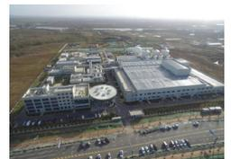
In Hefei Xiaomiao Organic Waste Treatment Center Project, i rifiuti organici vengono pretrattati e trasformati in biogas attraverso la digestione anaerobica in un impianto di quasi 67.000 metri quadrati. Due gruppi elettrogeni a biogas Jenbacher J420 alimentano l'impianto e forniscono energia anche alla rete locale.
