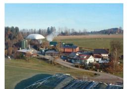
독일 Heslerhof 농장의 바이오가스 발전소는 엔바허 J420 엔진을 설치하고 대형 완충 저장 탱크 및 가스 저장 탱크에 투자하여 전력 시장 중심의 유연한 운영이 가능한 재생 에너지 저장 발전소로 전환했습니다. 이 농장은 자체적으로 전력을 생산하여 필요한 모든 전력을 공급하고 남은 전력은 매력적인 발전차액지원제도에 의해 시장가격으로 전력망에 공급합니다.
