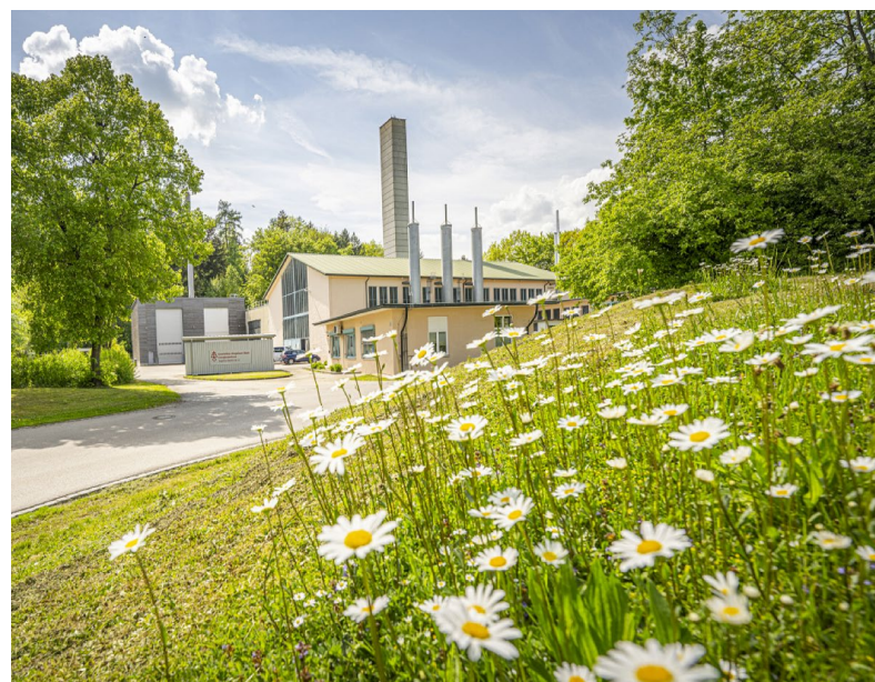
Das Energiezentrum des DRW in Ursberg. Hier werden täglich bis zu 4.000 Menschen mit Strom und Wärme versorgt.
