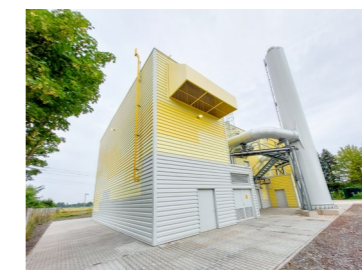
Stadtwerke Leipzig, Lausen
